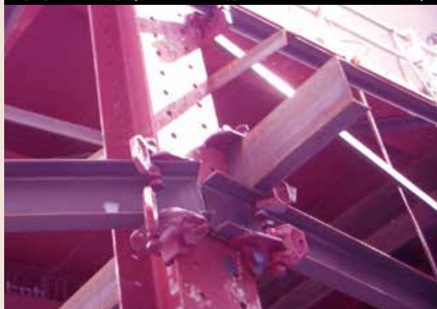
水平つなぎ材 (杭につなぎ材のジョイントがある場合)
