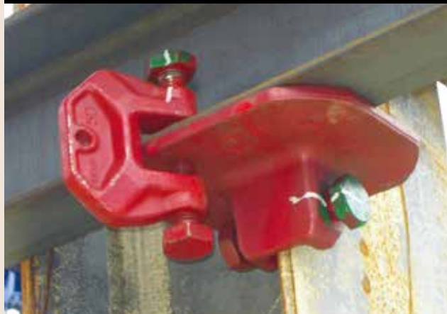
水平つなぎ材 (杭につなぎ材のジョイントがない場合)
